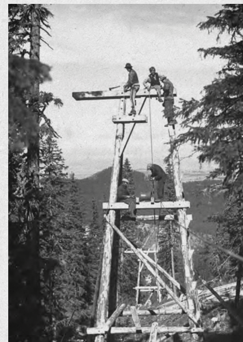
Drewniana podpora pomocniczej kolejki transportowej na Kasprowy Wierch, 1935.
